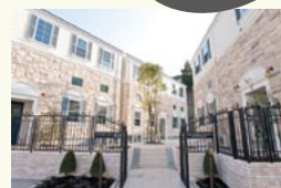
伝統的洋館建築デザイン。空室待ちが後を絶たない
